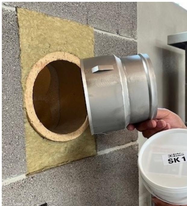
Adapterstück für den Zugbegrenzer mittels Säurekitt in den Rauchrohranschluss einkleben. Achtung: Nicht zu tief nach hinten schieben!
