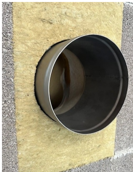
Adapterstück im eingeklebten Zustand.
