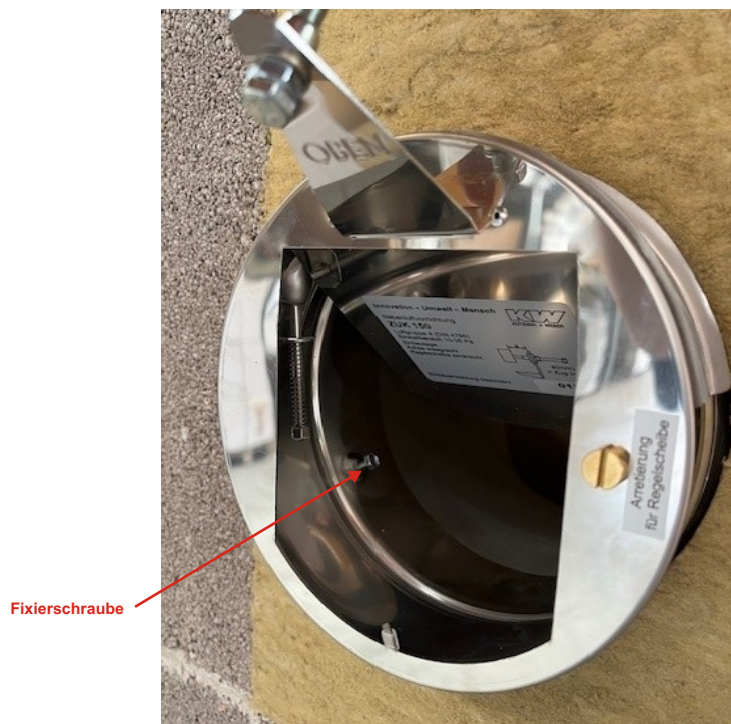
Mittels der Fixierschraube den Zugbegrenzer in der Sicke des Adapterstück fixieren.
