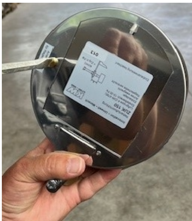
Beim Zugbegrenzer die Arretierung für die Regescheibe entsperren.
